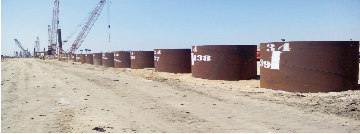
أعمال دق الخوازيق للأرصفة البحرية
