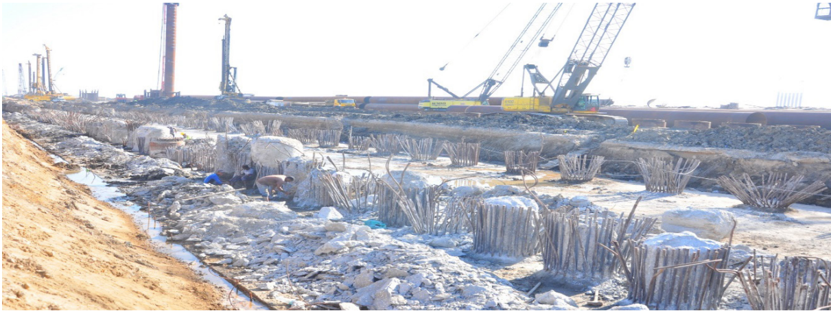
أعمال تجهيز تجربة التحميل بساحات التداول
