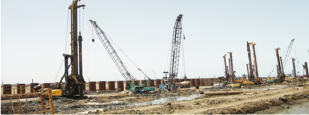
أعمال حفر وصب الخوازيق الخرسانية للأرصفة
